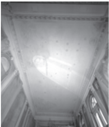
Abb. 4c: Decke des Konzertsaals im Marmorpalais, Zustand der Decke vor der Rekonstruktion (1995)
