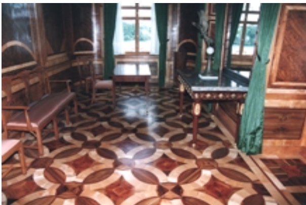
Abb. 5d: Parkettfußboden des Schreibkabinetts im Marmorpalais, Zustand nach der Rekonstruktion (1997)
