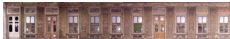
Abb. 2: Nibelungenfries im Schlosshof (Zustand 1996), Bildplan aus elf einzeln entzerrten Messbildern (Originalmaßstab 1:20)
