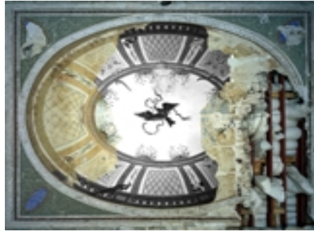
b) Überlagerung eines entzerrten Messbildes nach der Sicherung der Decke (1998) mit einem historischen Messbild (um 1912)
