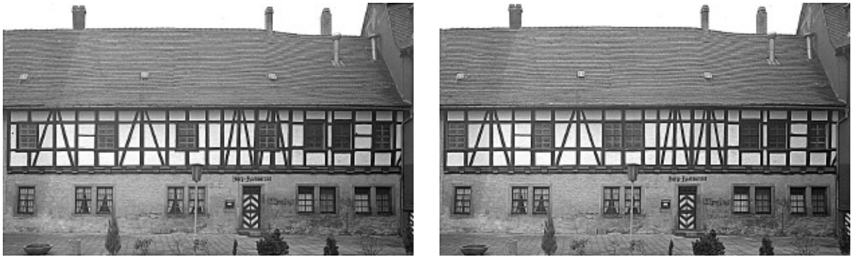
Abb. 8: Kapellendorf, Wasserburg, links: Überlagerung des digital entzerrten Messbildes des heutigen Zustandes mit CAD-Daten für die Rekonstruktion, rechts: Digitale Visualisierung für die Wiederherstellung des ursprünglichen Zustandes (s. Farbtafel VI, 2)
