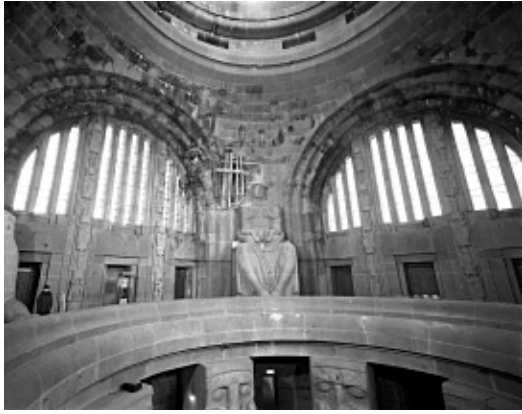
Abb. 5: Leipzig, Völkerschlachtdenkmal, Kuppelhalle (Grundlage für die Vorplanung und die Schadensdokumentation), links: Ausgangsbild, gescannt mit Kodak PhotoCD Pro (Auflösung 4096 x 6144 Pixel), rechts: Bildplan der Zylinderprojektion, Originalmaßstab 1:50 mit Angabe der Profillinie
