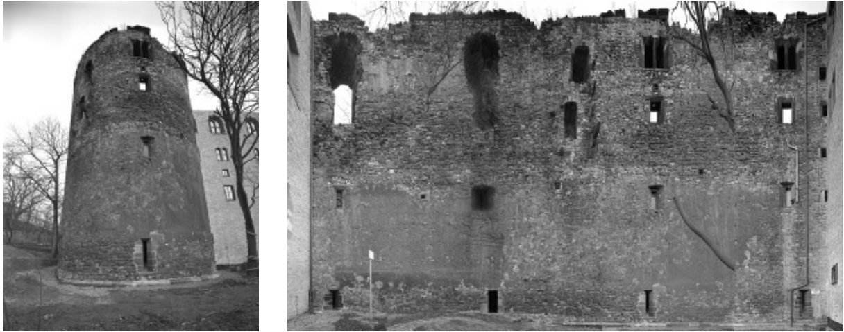
Abb. 3: Halle a.d. Saale, Moritzburg, West-Turm (Ergänzung zur graphischen Stereomessbildauswertung für die Bauforschung), links: Ausgangsbild, gescannt mit Kodak PhotoCD Pro (Auflösung: 4096 x 6144 Pixel), rechts: Bildplan der digitalen Abwicklung im Maßstab 1:50 (Montage aus sieben abgewickelten Aufnahmen, Umfang ca. 270°)
