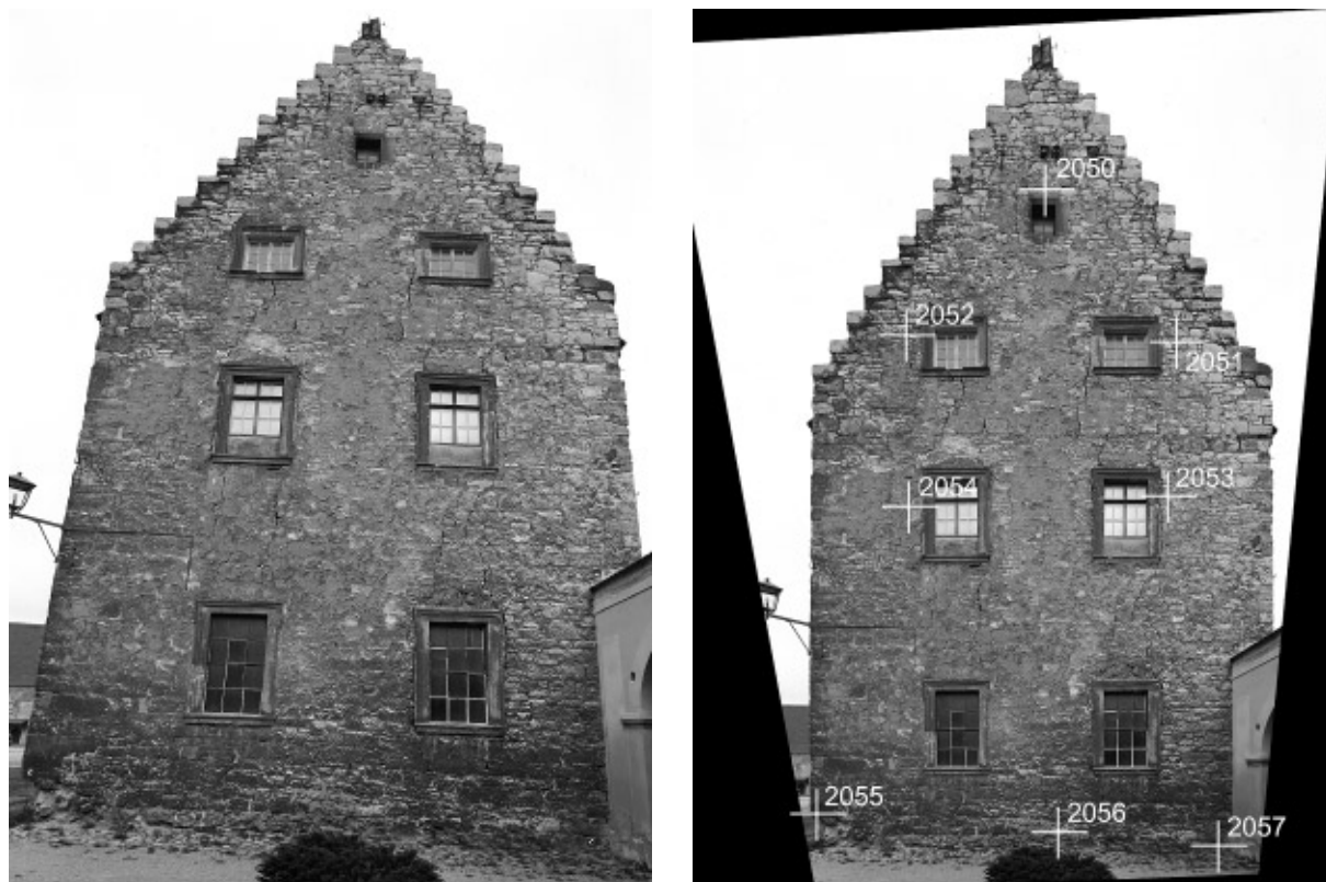
Abb. 1: Freyburg a.d. Unstrut, Neuenburg, (Kartierungsgrundlage für die Bauforschung), links: Ausgangsbild, rechts: Digitale Bildentzerrung mit den für die Entzerrung verwendeten Passpunkten, Originalmaßstab 1:50
