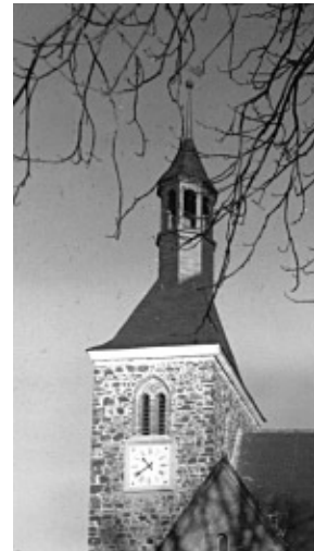
d) nach der Rekonstruktion
